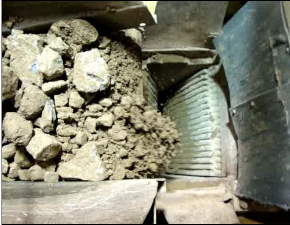
Abb. 1: Kegelbrecher im Betrieb
