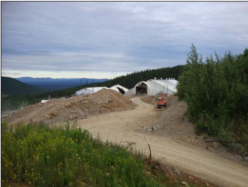
Abb. 4: Hochgradiges Lager (Links) und Mittelgradiges Lager (Rechts) oberhalb des Primärbrechers
