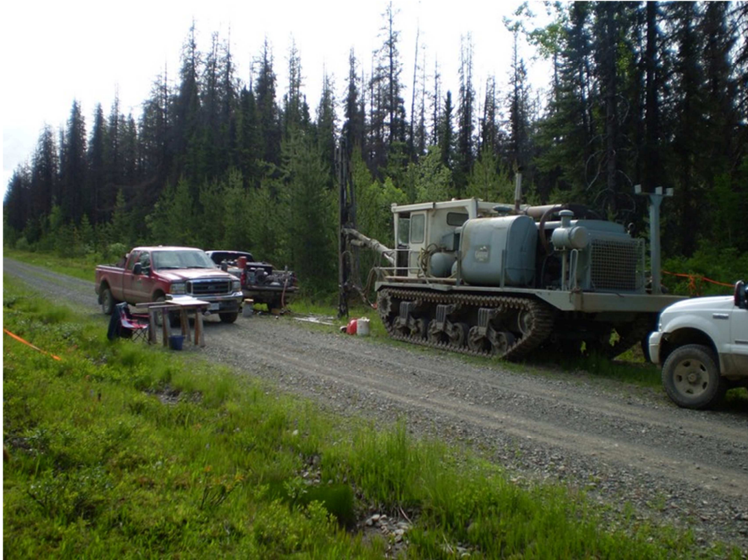
Bohrung von Orestone an der Straße – das Projekt Captain
