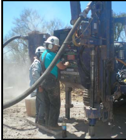
Abbildung A1: Herumgehen (links) und Bohrungen (rechts) mit dem Reverse-Circulation-Bohrgerät Prospector II beim Konzessionsgebiet Don Luis in Sonora, Mexiko.
